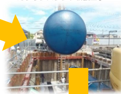
ガソリンスタンド新設工事
