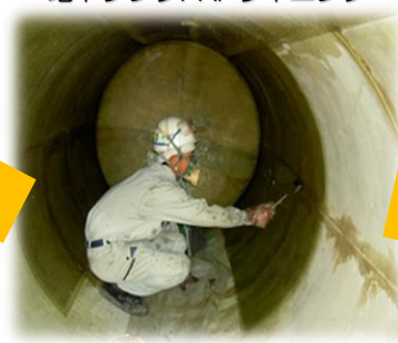
地下タンクFRPライニング
