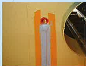
2. リークモニターセンサーラインを設置
