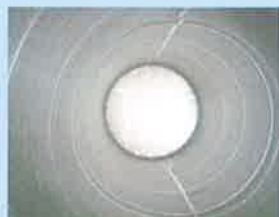
3. 特殊アルミシートを貼り付けダブルウォールの間隙を作る
